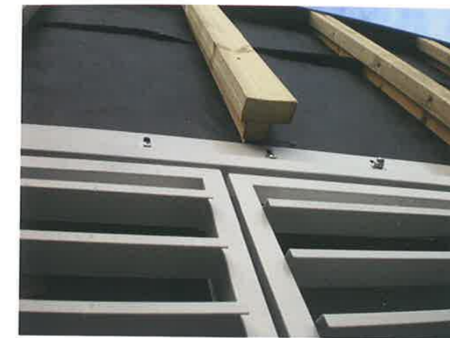
Gli elementi schermanti delle aperture vetrate al piano terra e dettaglio dei montanti che sostengono le doghe metalliche della facciata.
